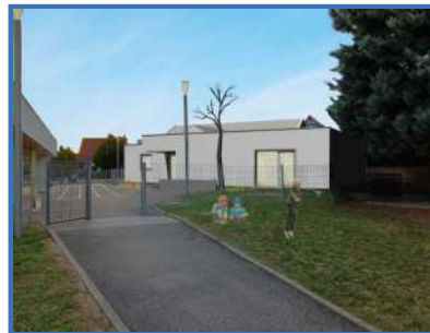
Rénovation et agrandissement de la cantine / périscolaire
